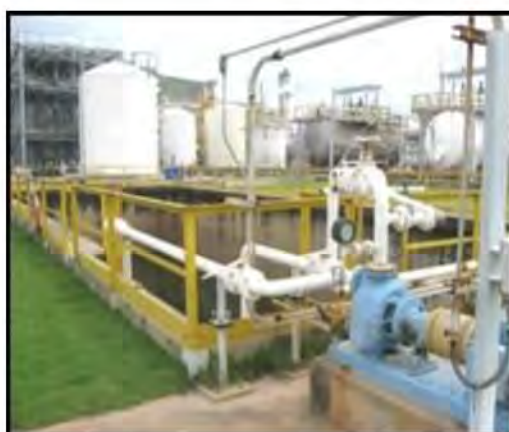
ภาพที่ 2.2-20 ลานถัง และบ่อร์องรับสารเคมีหากเกิดการรั่วไหล
