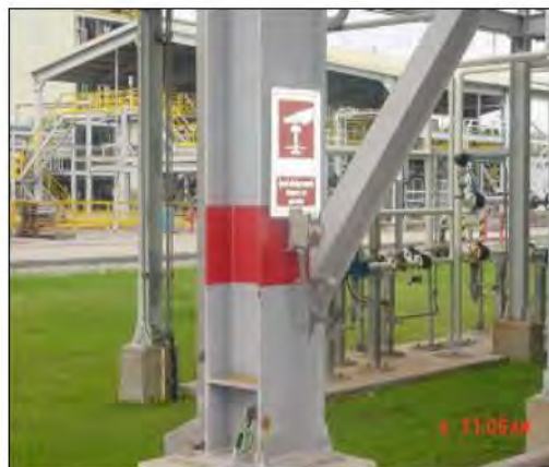
ภาพที่ 2.2-21 ปุ่มกดแจ้งเหตุสัญญาณฉุกเฉิน
